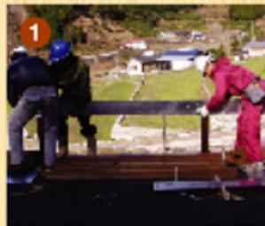
1 既設支柱に鋼材プレート取付
